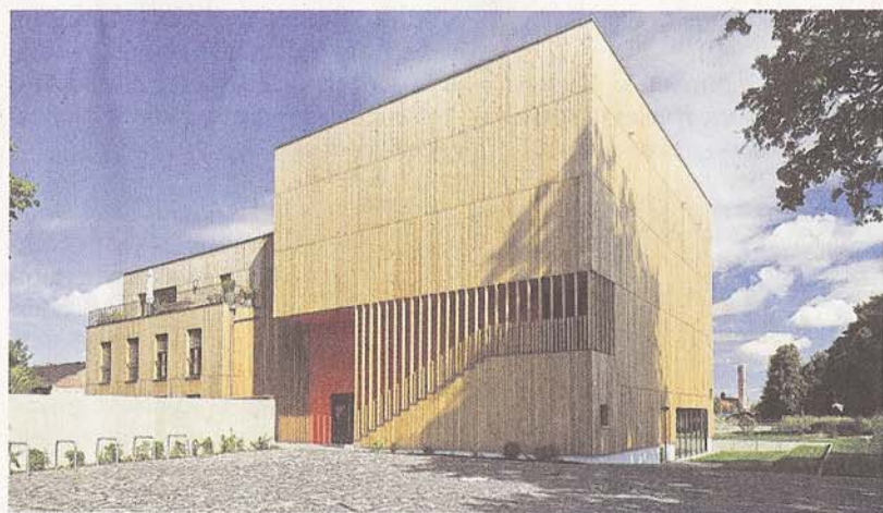
Von außen wirkt die neue Kirche der alt-katholischen Gemeinde wie ein reiner Zweckbau.
